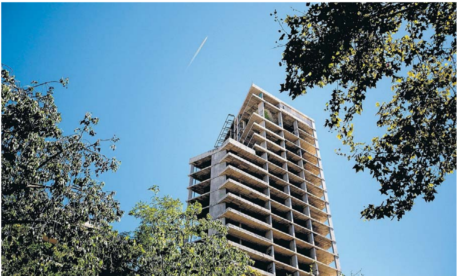
Un edifici en construcció al Fòrum de Barcelona. PERE TORDERA
